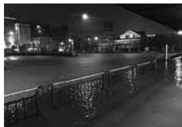
平成29年台風第21号で冠水した宇治山田駅周辺
